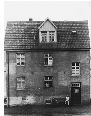
Die "Molkerei", 1924 bereits als Wohnhaus genutzt.
