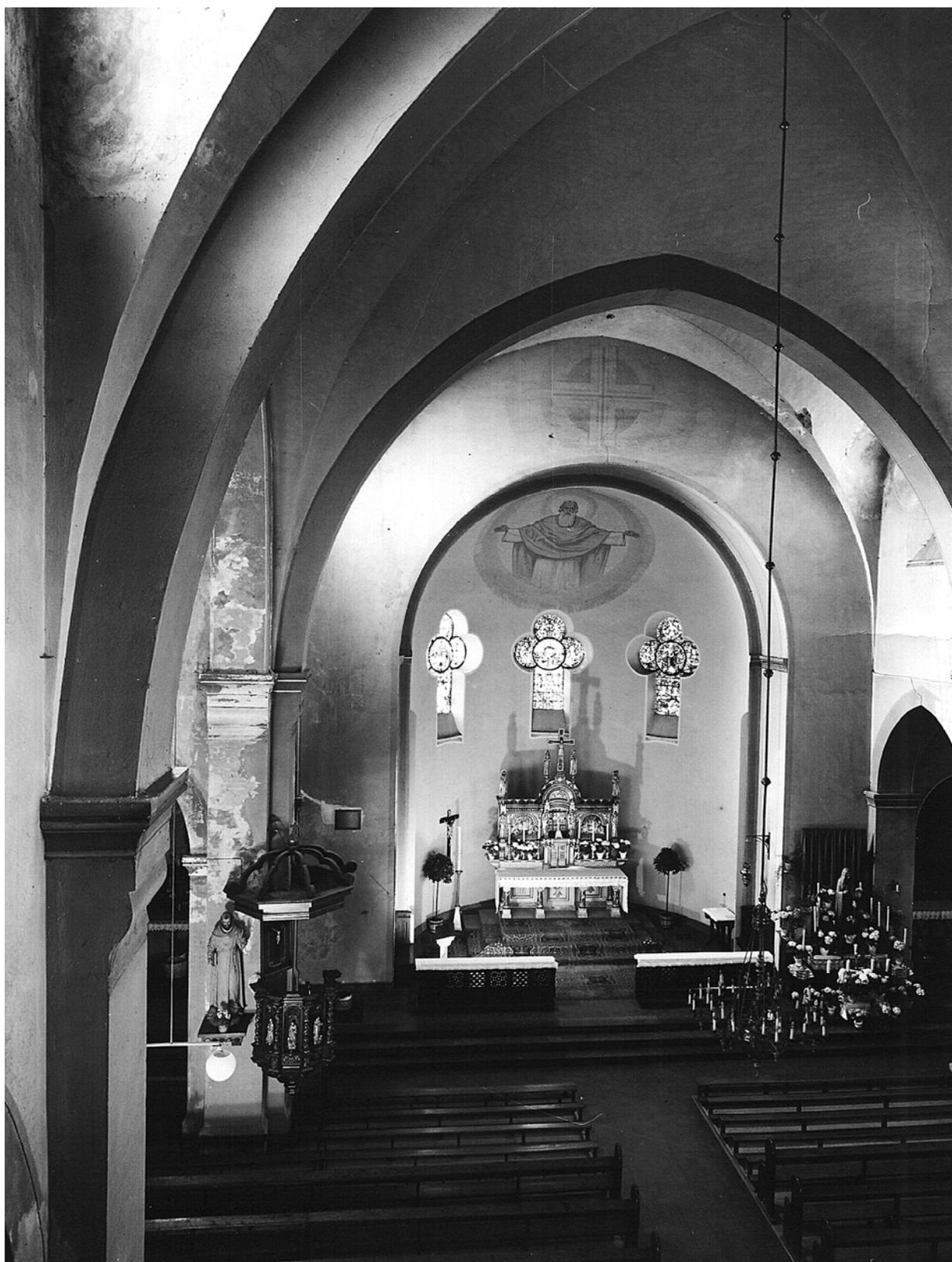
Der Kirchenraum nach der ersten Restaurierung im Jahre 1941. Die Aufnahme wurde nach dem Kriege gemacht. Deutlich sind Wasserschäden an den Wänden als Folge der Kriegseinwirkungen zu erkennen.
