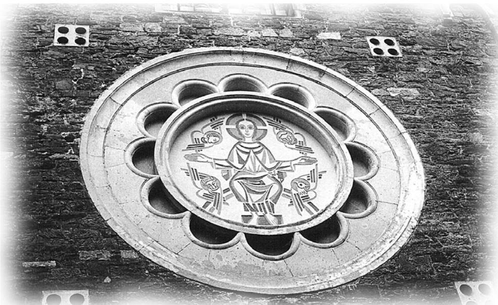
Die durch Granattreffer zerstörte Fensterrosette wurde massiv ausgemauert und mit einem farbigen Christusbild in Kratzputztechnik geschmückt.
