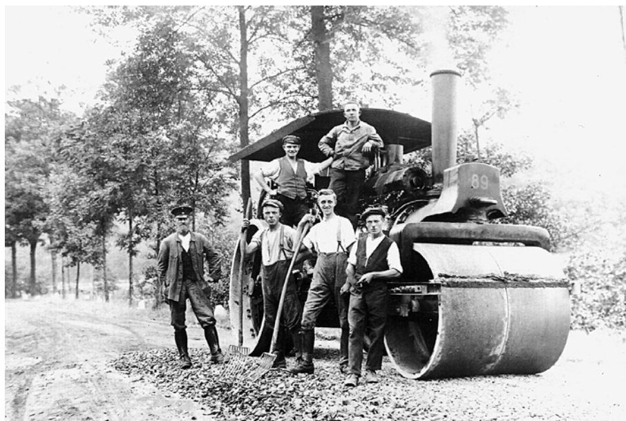
Theodor Reuter, links, mit Arbeitskolonne und Dampfwalze beim Straßenbau
