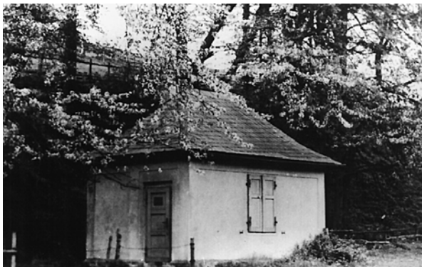
Ehemaliges Pumpenhaus des Wasserwerks Heggen im Sanger Wiesental – 1973/74 stillgelegt.
